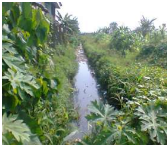
RIGOLE OCCASIONNANT LES INONDATIONS
