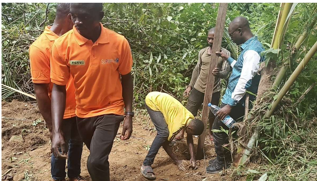
Photo du comptoir en construction au bord du Ntem à Mabiogo (lieu-dit débarcadère)
